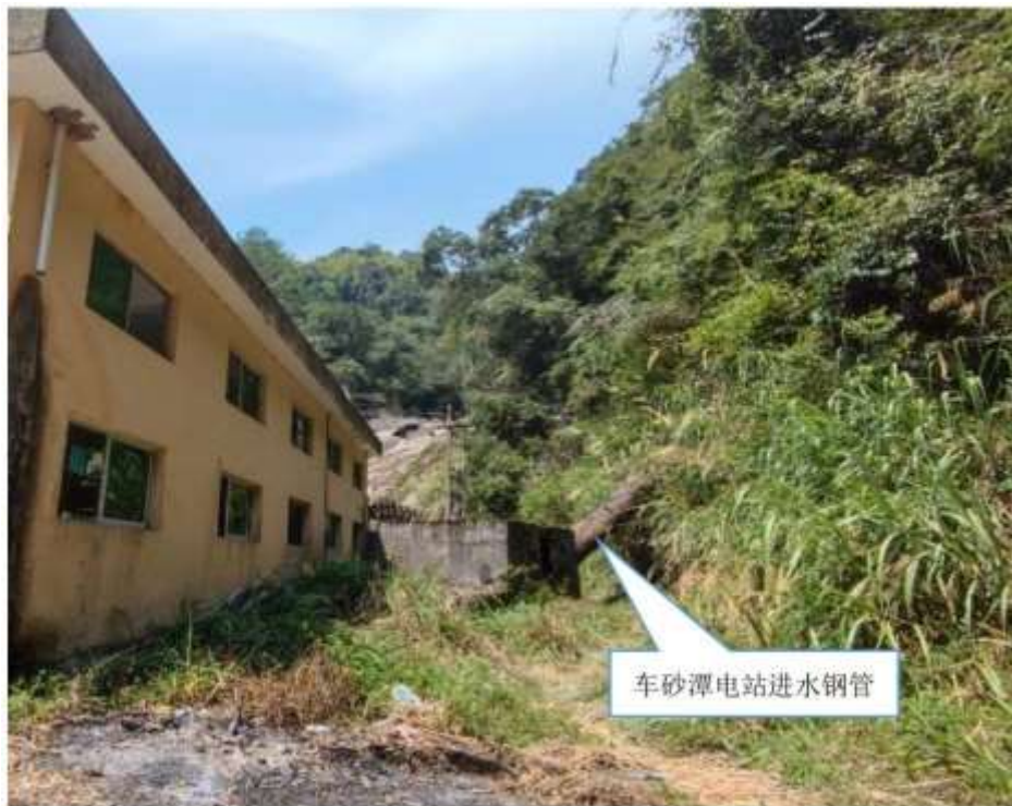
图3.6-1 车砂潭电站现有钢管处
