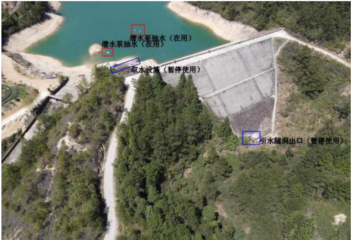
图3.5-1 纯池水库现有取水设施
